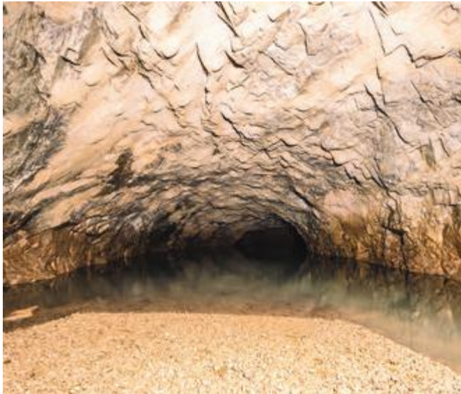
Zur Vergrößerung des Tagesspeichers Naßfeld wurde ein zwei Kilometer langes Kavernensystem aus dem Berg gebrochen.
