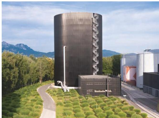
Der 44 Meter hohe Wärmespeicher neben dem Heizkraftwerk Salzburg kann ca. 30 Millionen Liter Heißwasser aufnehmen.
