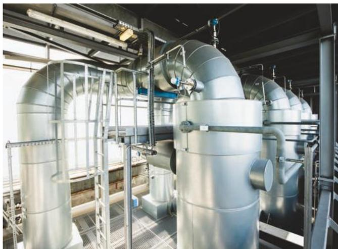
In der Umformerstation beim Heizkraftwerk Nord fließt Wärme aus Industrie und Biomasse-Heizwerken in den Wärmespeicher.
