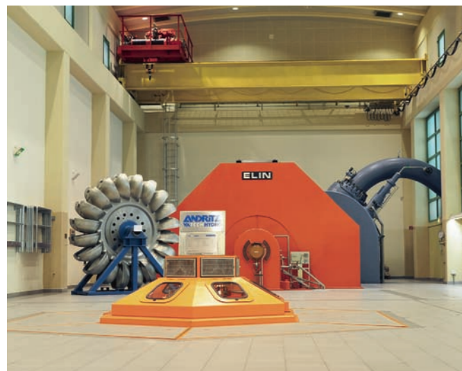
Mit 104 Megawatt Engpassleistung ist Hintermuhr das größte Kraftwerk der Salzburg AG.
