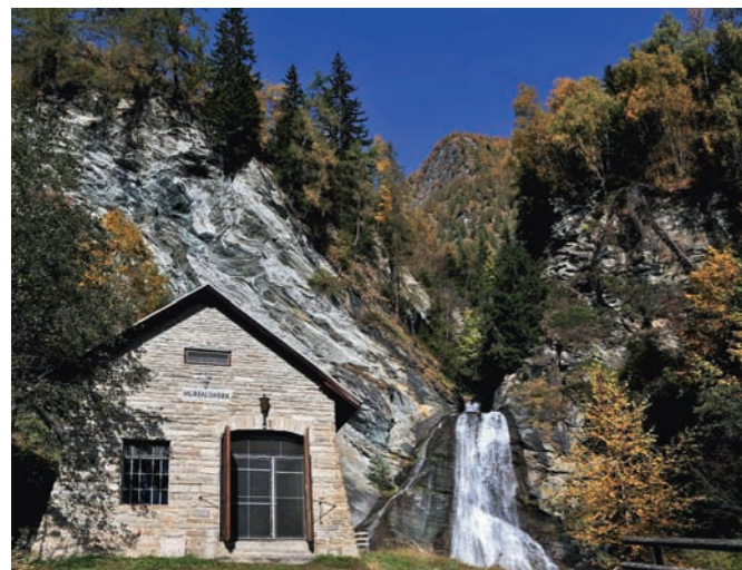
Heute ist das Kraftwerk Murfall mit 780 Kilowatt Leistung ein Kleinwasserkraftwerk.
