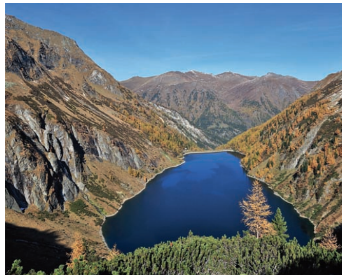
Das Kraftwerk Hintermuhr nutzt Wasser aus dem Rotgüldensee, dem oberen Mur-, Muritzen- und Altenbergtal.
