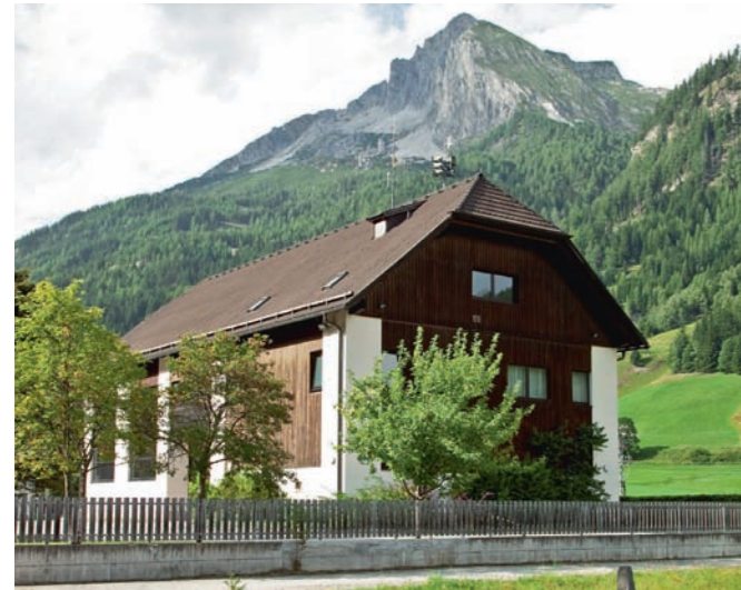
Das Krafthaus liegt nördlich von Zederhaus, neben Zederhausbach und Tauernautobahn.
