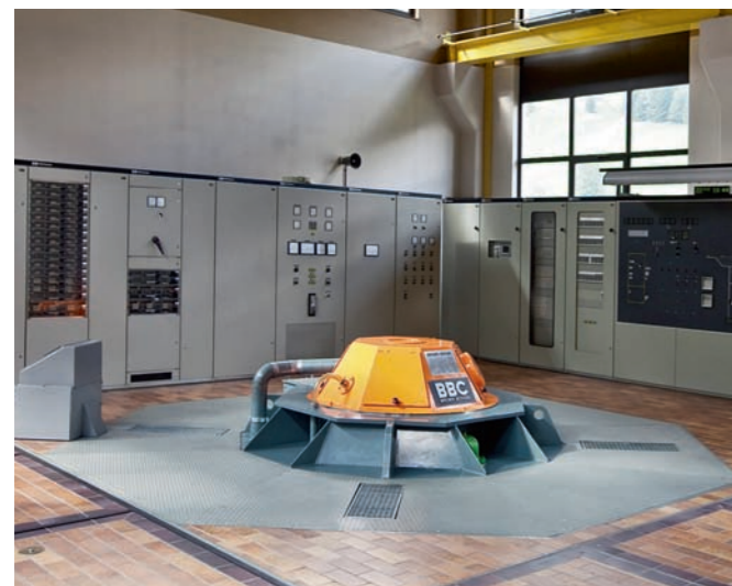
Francis-Turbine und Generator erbringen im Krafthaus Zederhaus 10 Megawatt Leistung.
