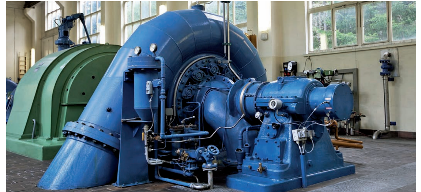
Die Pelton- und die Francis-Turbine treiben einzeln oder gemeinsam denselben Generator an.
