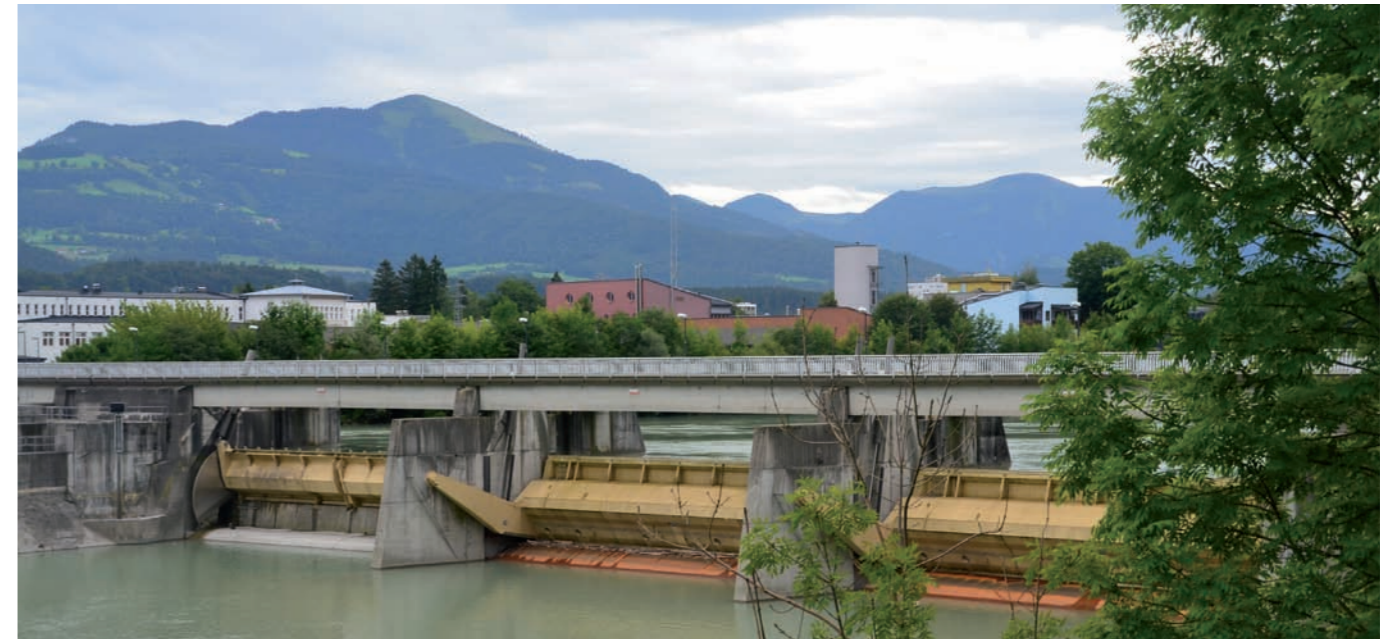
Kraftwerk Sohlstufe Hallein
