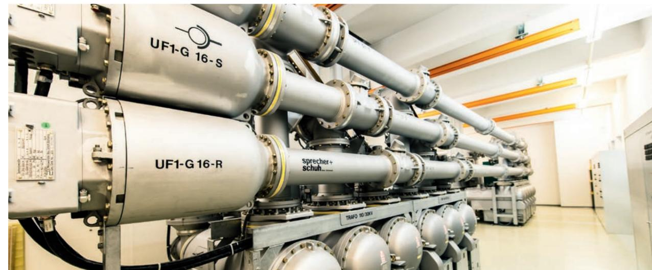
Das Kraftwerk Bockstein war die erste Anlage in Salzburg mit einer „110 kV SF6-Innenraum-Schaltanlage“.
