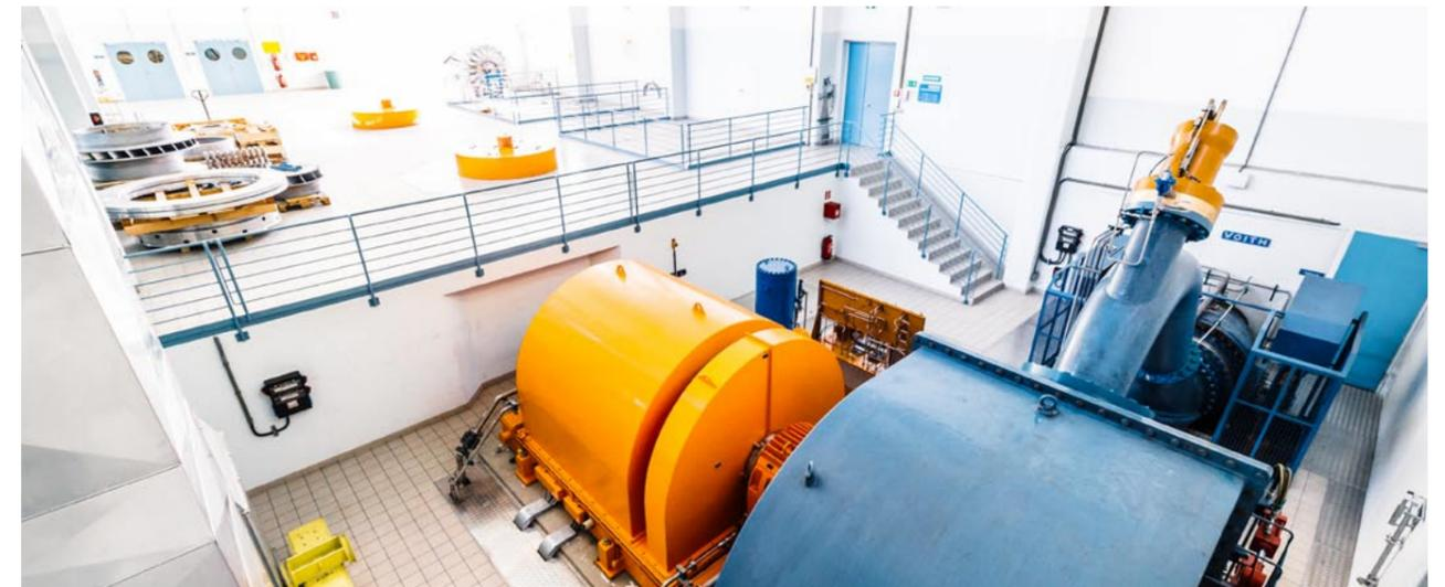
Das Krafthaus ist mit zwei Francis-Turbinen und einer Pelton-Turbine ausgerüstet.
