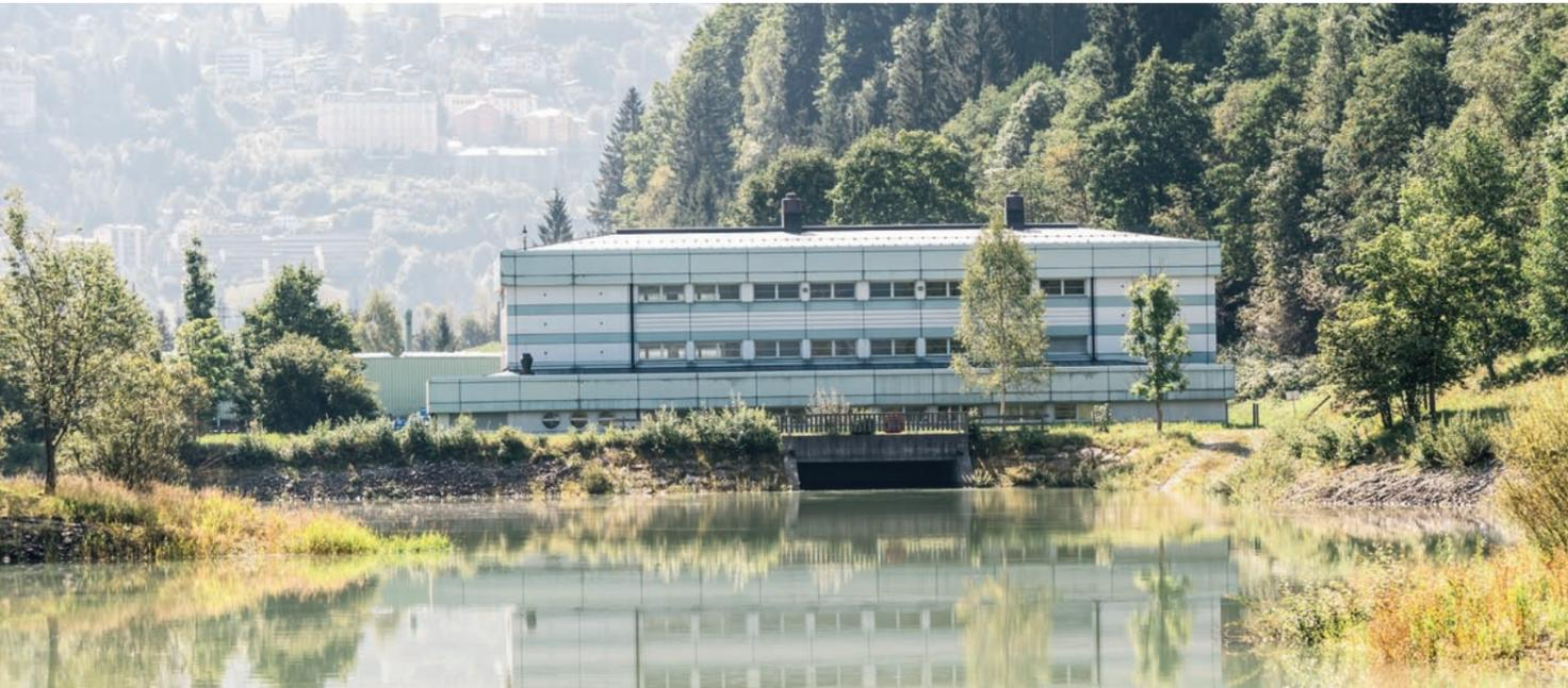
Im Talgrund zwischen Bad Hofgastein und Bad Gastein bei Remsach liegt das Kraftwerk Remsach. Die Anlage nutzt Wasser, das die Turbinenanlagen von Naßfeld und Bockstein bereits durchlaufen hat. Der Bockhartsee ist der Jahresspeicher für alle drei Kraftwerke. Nach dem Kraftwerk Bockstein fließt das Wasser in einem unterirdischen Druckstollen mit Schwalkammer fast fünf Kilometer quer durch den Stubnerkogel.
