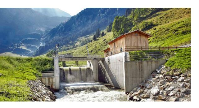
Das Kraftwerk nützt eine Gefällestufe der Fuscher Ache zwischen Ferleiten und Fusch. Der Tagesspeicher Ferleiten liegt auf etwa 1.130 Meter an einem beliebten Aussichtspunkt der Großglockner Hochalpenstraße. Hier wird Wasser aus der Ache gefasst und unterirdisch bis zum Krafthaus in Fusch geleitet.
